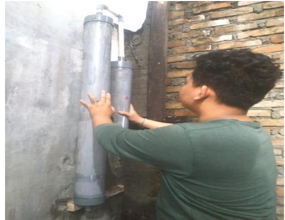
13. Pemasangan alat filtrasi dirumah Pak Ds
