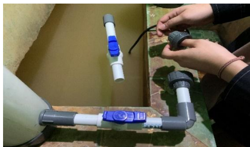
Gambar 15. Pemasangan filtrasi pada bak air sumur
