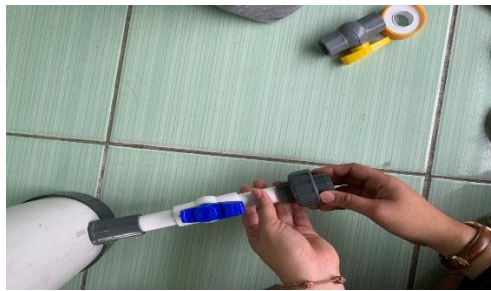
Gambar 11. Perakitan tabung filtrasi
