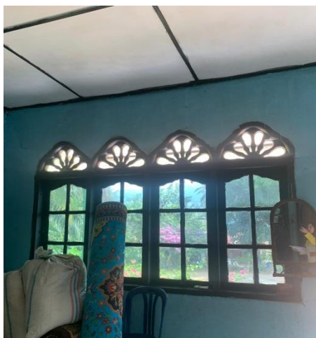
Kondisi Ventilasi Yang memenuhi syarat
