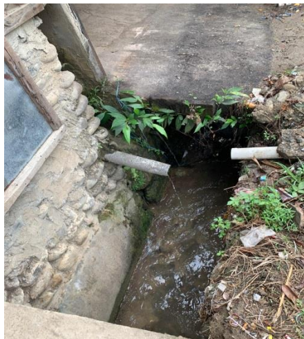
Selokan terbuka untuk pembuangan air limbah
