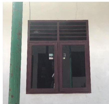
Gambar 6. Jendela dan ventilasi kantor
