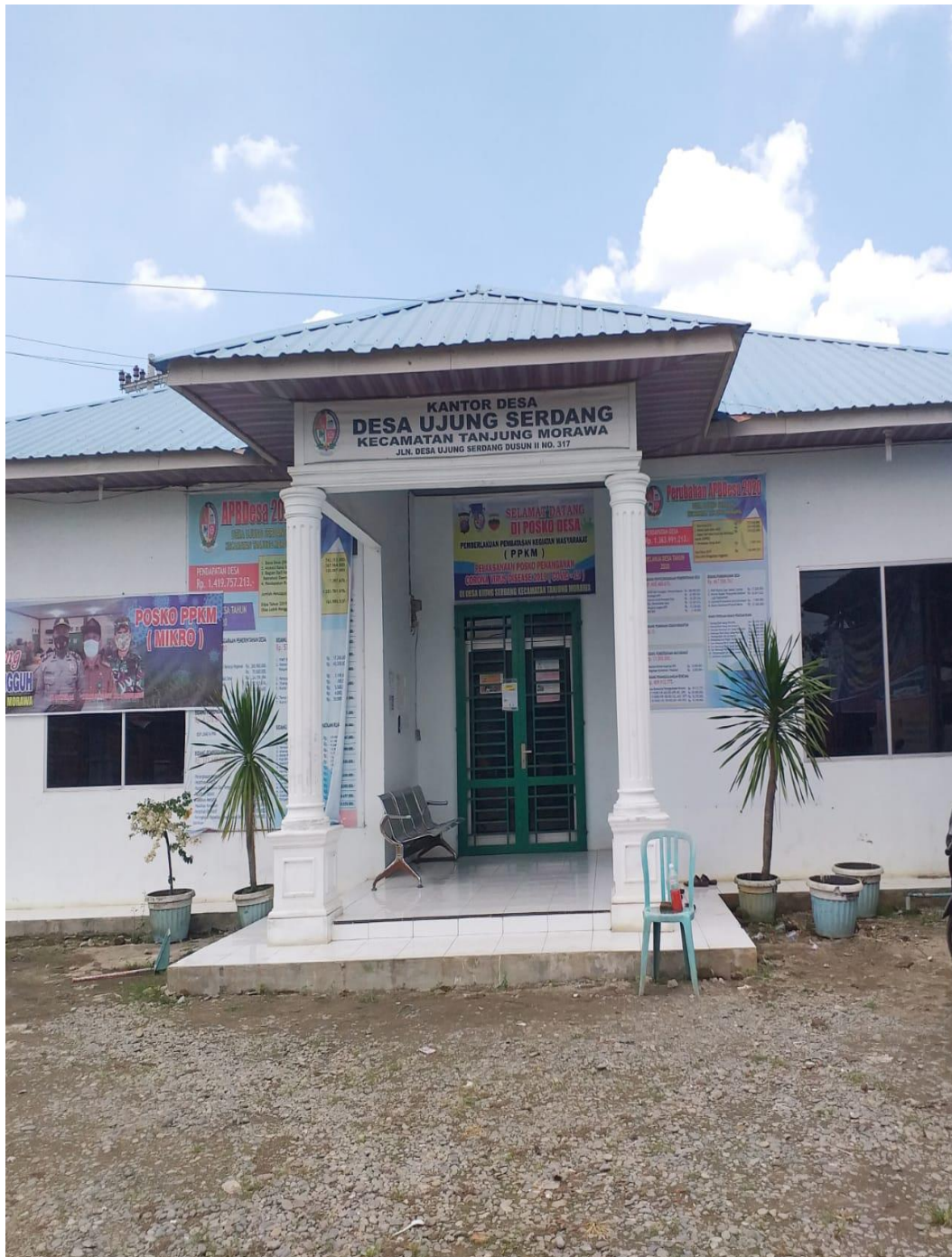
Gambar 2. Kantor kepala Desa Ujung Serdang Kecamatan Tanjung Morawa Kabupaten Deli Serdang.
