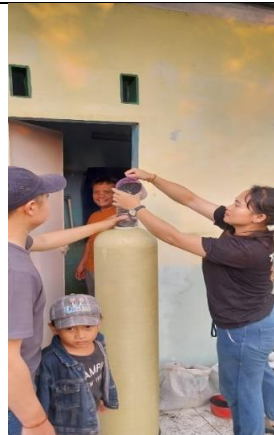
Menuangkan Media Filter ke dalam tangka filter
