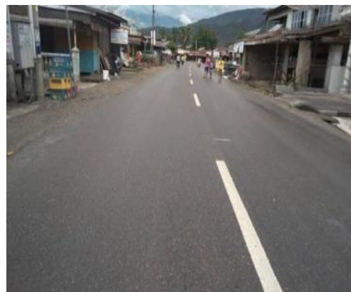
Jalan desa Tanpa Tempat sampah
