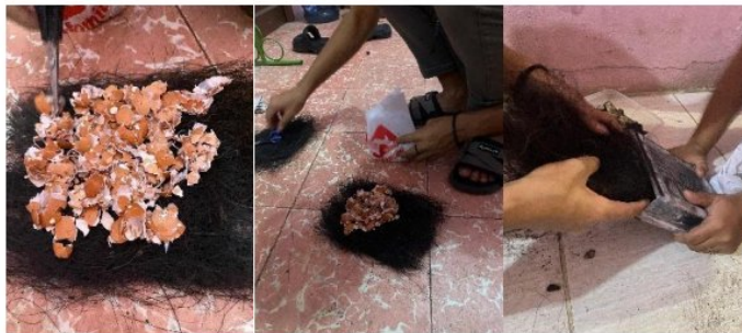
Gambar 3. Pembuatan filtrasi cangkang telur-ijuk
