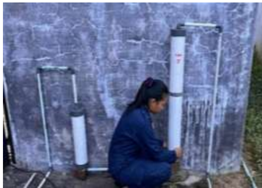
Gambar 17 dan Gambar 18 Proses pemasangan pipa filtrasi pada pipa III dengan waktu ( 5,10,15 menit )
